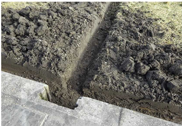
額縁明きよと排水溝を連結し、 降雨を速やかにほ場外に排水
