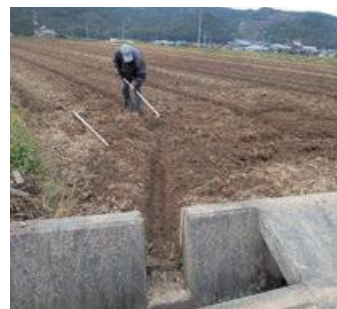
排水溝と落水口の連結
