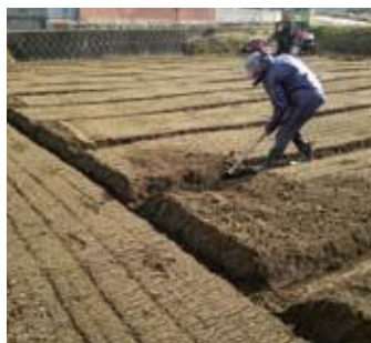
排水溝と排水溝の連結
