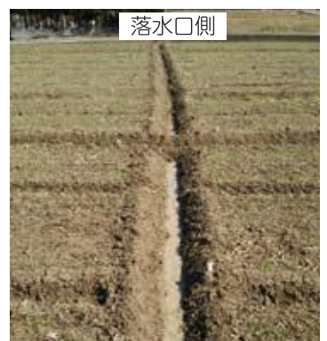
連結不足による滞水
