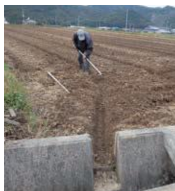
排水溝と落水口の連結
