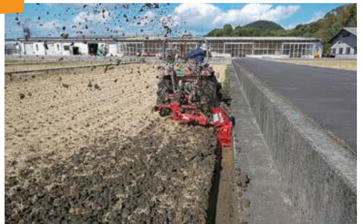
ほ場の畦周りに額縁明きょ(排水溝)設置
