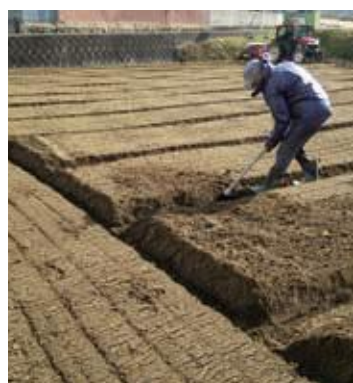
排水溝と排水溝の連結
