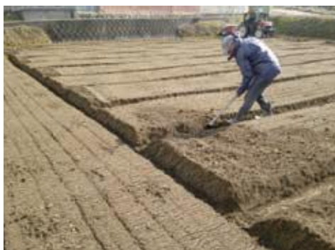
排水溝と排水溝の連結
