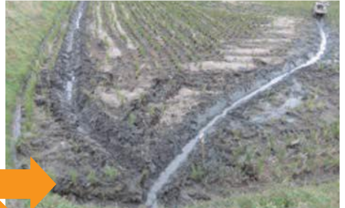
排水溝の設置
