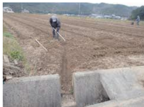
排水溝と落水口の連結
