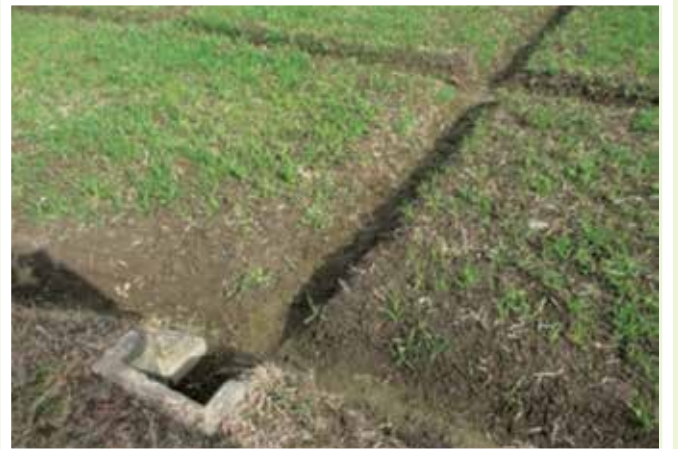
排水溝を落水口まで必ず連結
