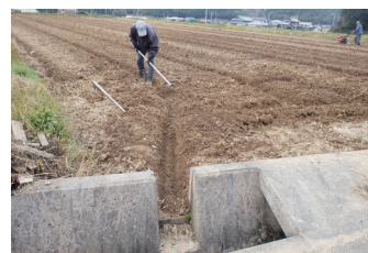
排水溝と落水口の連結
