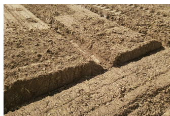
排水溝の設置と連結
