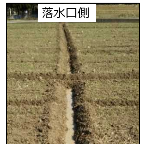
連結不足による滞水
