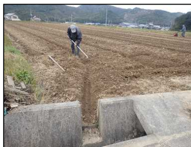
排水溝と落水口の連結
