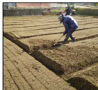
排水溝と排水溝の連結
